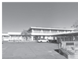
稲沢東公民館・はなみずき館
